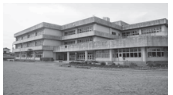
▲耐震補強工事が行われる中里小学校
