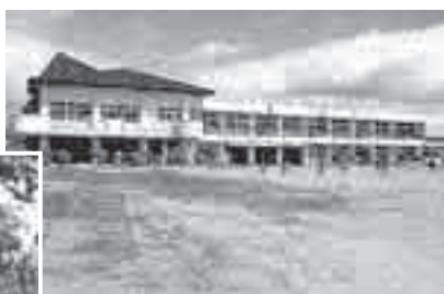
▲中津山第一小学校全景
