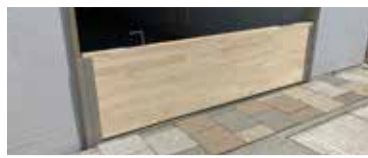
止水板設置の様子
