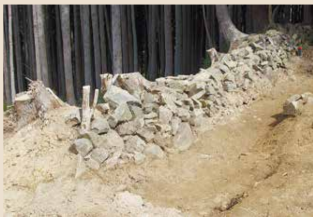
道路北側の石積み
