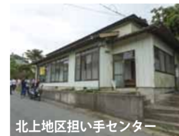
北上地区担い手センター
