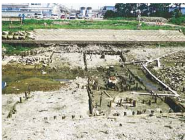
震災後、災害復旧工事で見つかった明治期の木製開門の基礎部分
