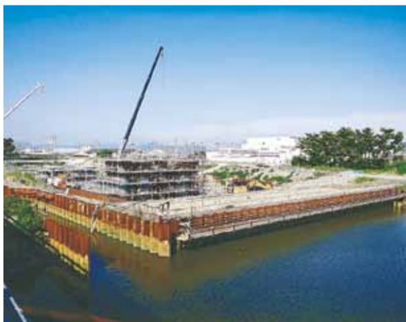
災害復旧工事が進む釜開門
