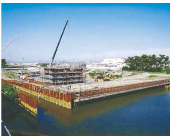
災害復旧工事が進む釜開門
