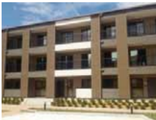
復興公営住宅
