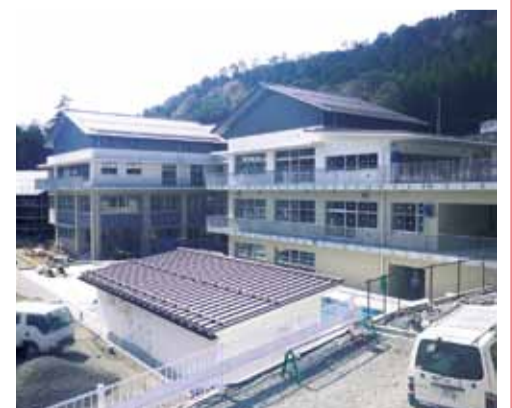
▲6月に完成予定の新校舎
