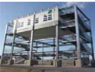
津波避難タワー
