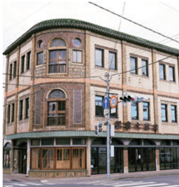
▲修理完成した「旧観慶丸商店」
