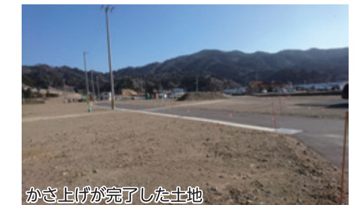
かさ上げを行い、道路を整備
