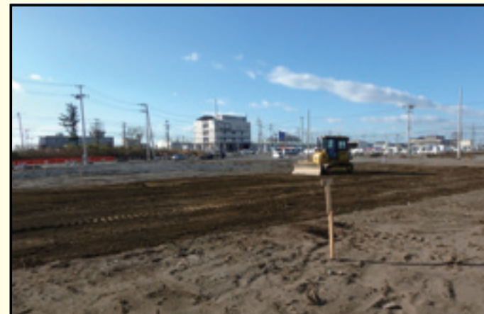
▲土地造成工事の様子
