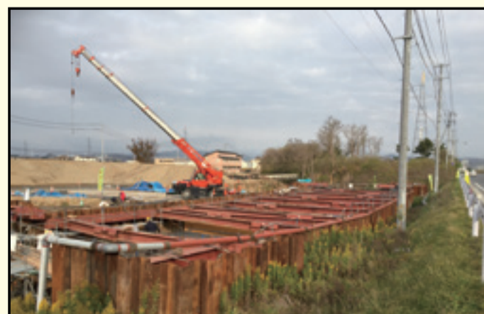
▲取付道路(水路)工事の様子
