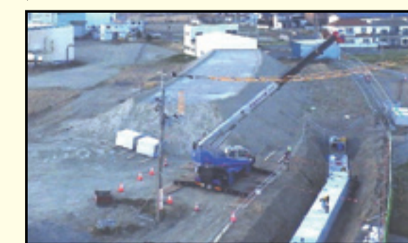
▲湊中央線道路築造工事の様子
