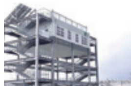
津波避難タワー
