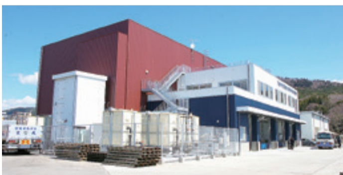
▲写真右側部分が市場、左側が製氷冷蔵庫です。震災前は別棟だった両施設を合築することにより、活魚の鮮度保持機能の向上を図っています。
