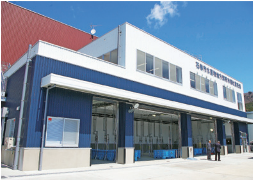
▲市場1階には、荷さばき室、放射能検査室のほか、ICカードによる自動型の水販売装置や接岸した漁船に直接砕氷を搬送する設備等を整備しました。
