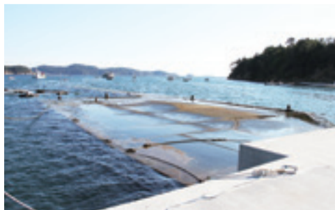
▲沈下した物揚場
