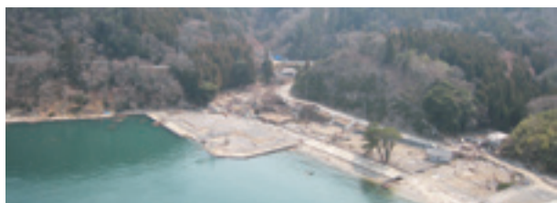
▲沈下した物揚場 (平成23年3月撮影)
