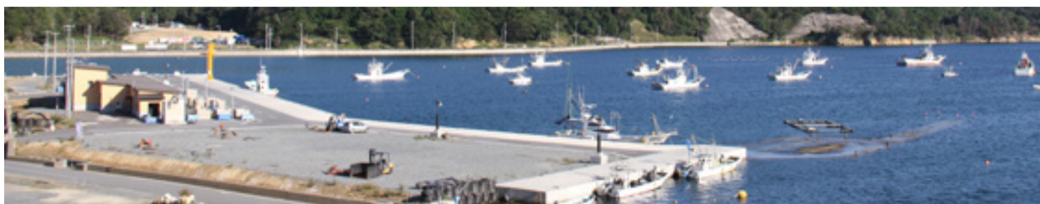
▲写真右側には、沈下した物揚場と防波堤が見えます。
