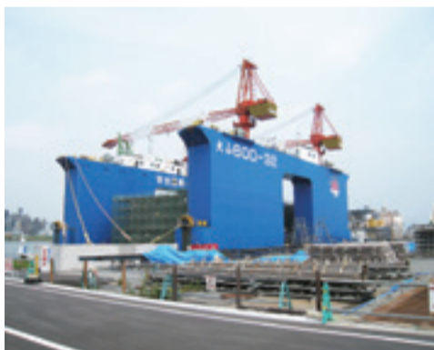
▲上の写真は、泊漁港で使用されるケーソンです。高さ9メートル、重さ約700トンの大きさです。(8月撮影) ケーソンは、フローティングドックという海上に浮かんだ設備で製作されます。(写真の青い部分がフローティングドック) 製作が完了すると、ドック自体を沈ませて完成したケーソンを引き出します。
