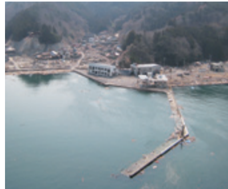
▲沈下した防波堤 (平成23年3月撮影)
