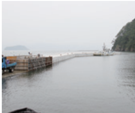
▲防波堤の整備が進められています。(8月撮影)
