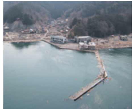
▲沈下した防波堤 (平成23年3月撮影)
