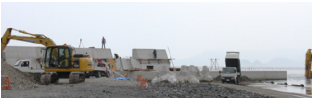
▲▼東防波堤(被災状況写真B)は、現在、復旧工事が進められています。(上: 8月撮影 下: 9月撮影)
