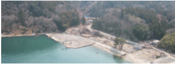
▲沈下した物揚場 (平成23年3月撮影)
