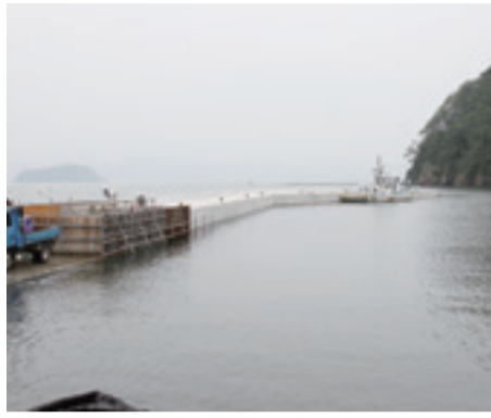
▲防波堤の整備が進められています。(8月撮影)
