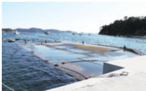
▲沈下した物揚場
