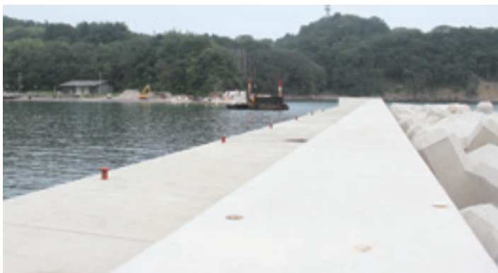
▲西防波堤(被災状況写真A)は消波工を除きおおむね完成しました。(8月撮影)
