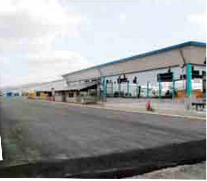
石巻漁港道路 ⑤ 石巻漁港臨港道路災害復旧工事により、一部整備されました。
