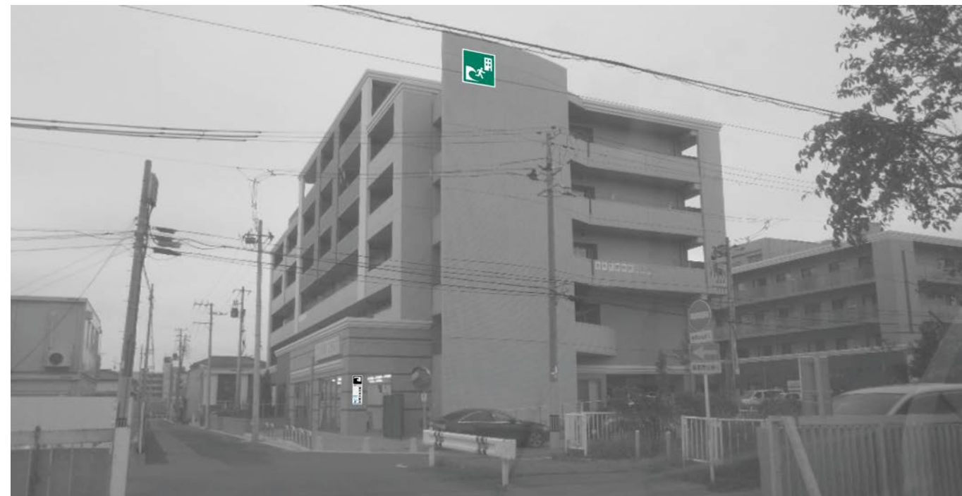
避難先サイン 建物(津波避難ビル)、東日本大震災津波実績浸水深サイン
