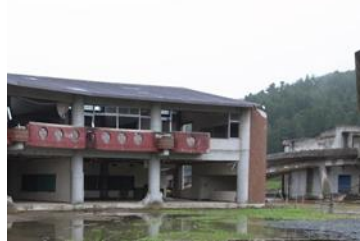
震災遺構として保存が決定した大川小学校旧校舎
