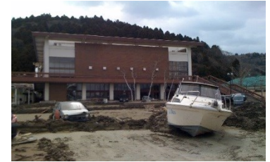
被災した石巻市民会館
