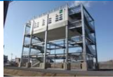
魚町1丁目地区津波避難タワー（H27建設）
