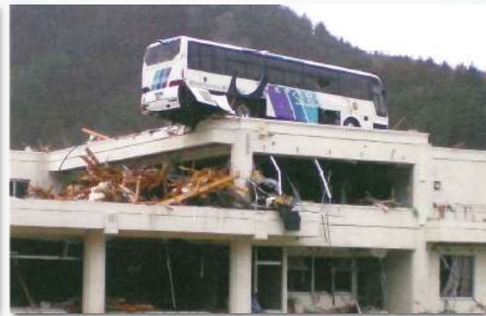
津波で公民館の屋上まで運ばれた大型バス
