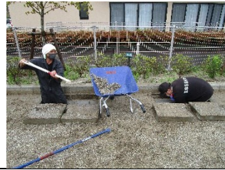
側溝の砂上げ
