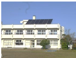
完成した太陽光パネル
