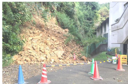
崖崩れ箇所(裏山への避難経路)
