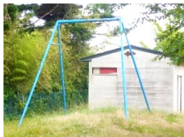
撤去するターザンロープの支柱
