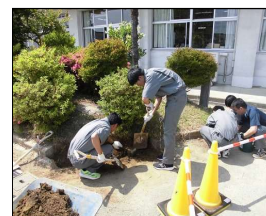
基礎部分からしっかり！
