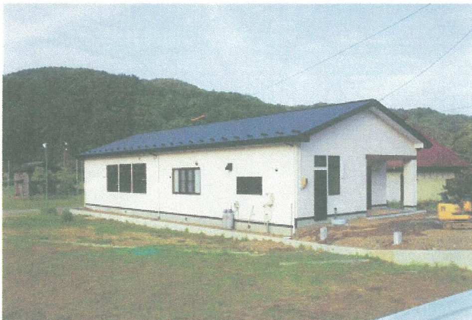
完成後の北上公民館女川分館
