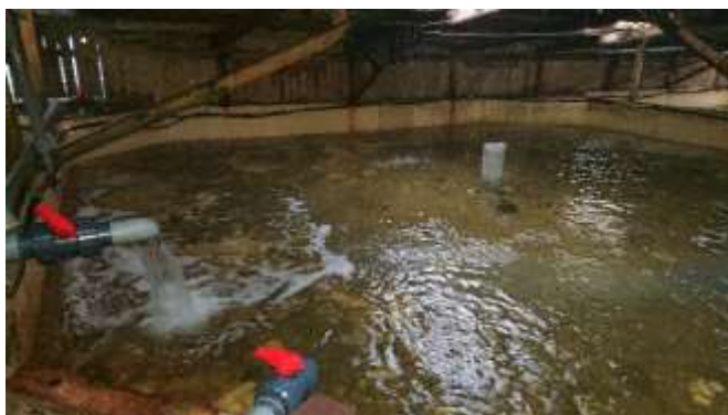
【ヒラメ養殖場】常時海水ポンプで海水循環されている。
