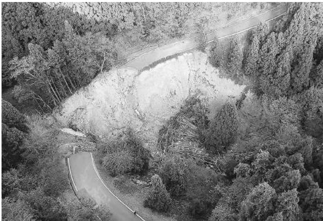
崩落した市道小竹浜蛤浜線
