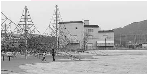
ちびっこ広場から見る南境排水ポンプ場
