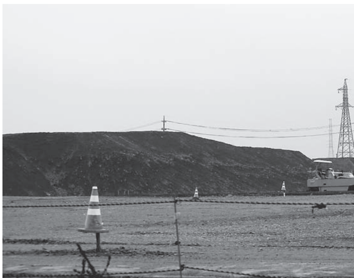
▼造成工事中の復興公営住宅整備予定地(新蛇田地区)
