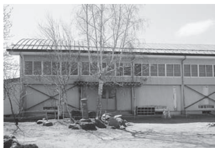
▲解体後、新築される向陽小体育館
