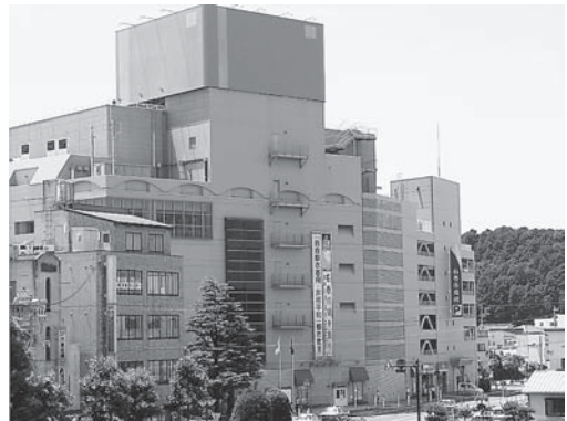
▲石巻市役所本庁舎
