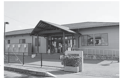
向陽地区コミュニティセンター ▶
