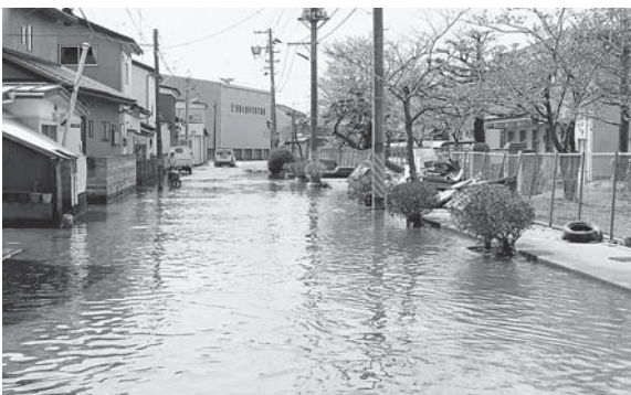
▲地盤沈下による浸水（渡波地区）
