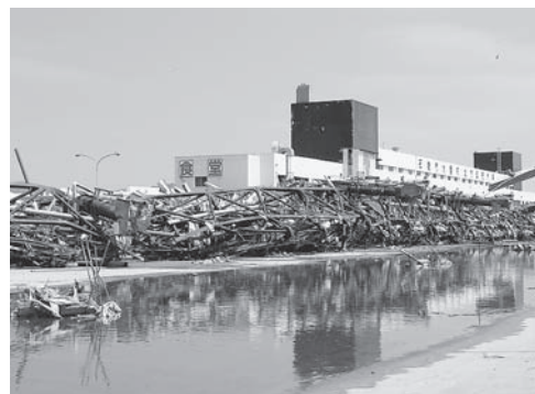
◀被災した石巻魚市場
