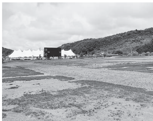
▲砂利が敷かれ修復が必要なフットボール場
