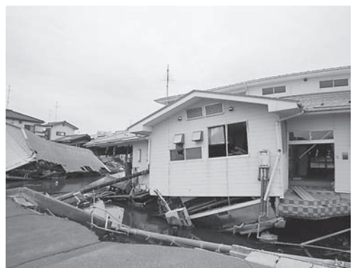
▲被災した石巻市立はまなす保育所
