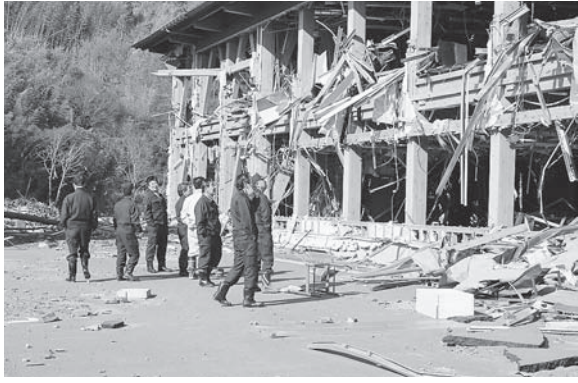
▲津波により全壊となった北上総合支所
