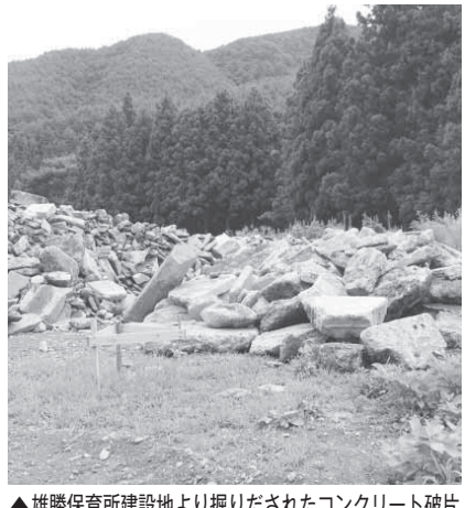
▲雄勝保育所建設地より掘りだされたコンクリート破片
