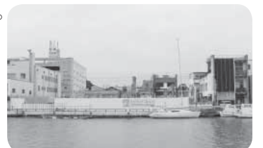
解体された旧丸光▶
