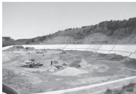
▲埋立処分場（大衡山）
