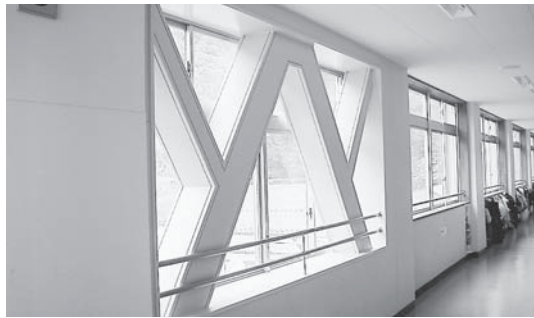
耐震補強実施校
