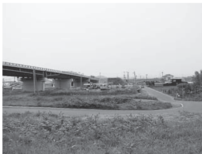
工事が進む(仮称)石巻北部バイパス
