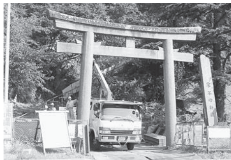
大門崎公園への登り口の治山工事
