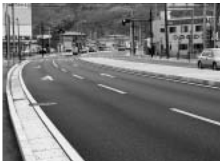
「河南川尻線」(元倉二丁目地先)
