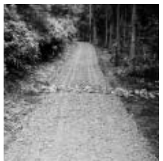
桃生地区の森林作業道
