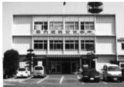
石巻市役所本庁舎
