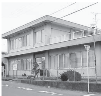
広瀬農業担い手センター
