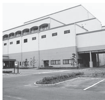
石巻広域クリーンセンター
