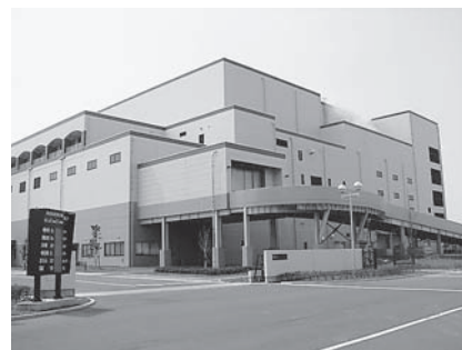
石巻広域クリーンセンター
