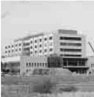
建設中の新石巻赤十字病院
