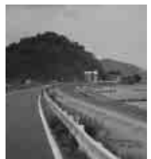
北上総合支所付近
