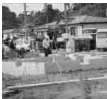
建設中の河北地区市営住宅
