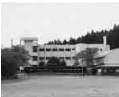
除去工事が完了した大原中学校
