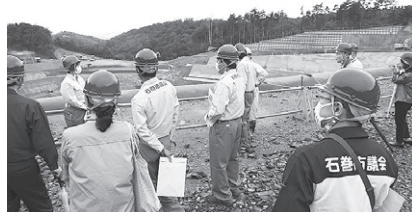
一般廃棄物最終処分場建設現場 現地視察
