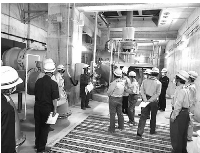
石巻港排水ポンプ場 現地視察
