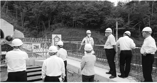
渡波稲井線道路新設工事 現地視察
