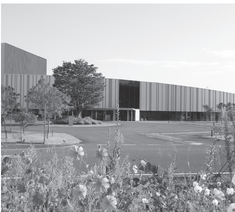
改修工事を行う遊楽館
