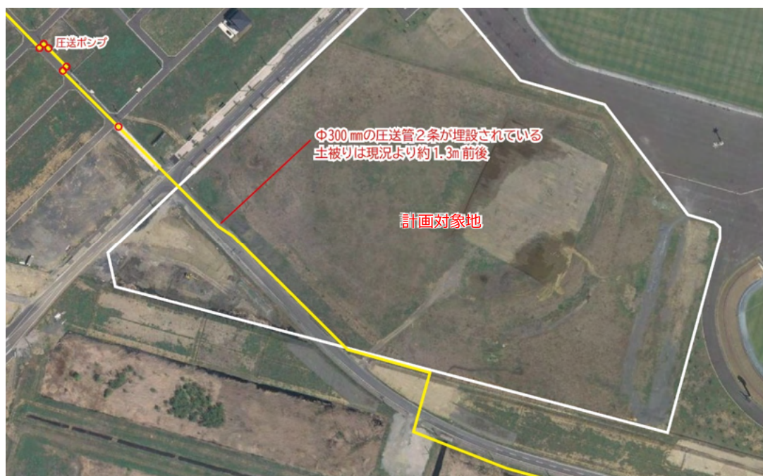
図 21 河北桃生幹線敷設状況
