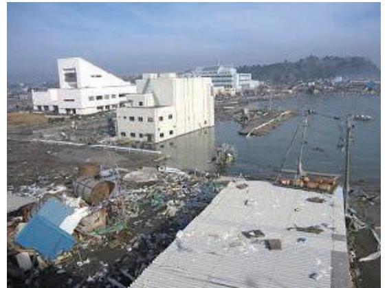
被災した石巻文化センター（左上）写真：石巻市
