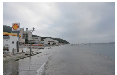
1m以上の地盤沈下（鮎川港）
