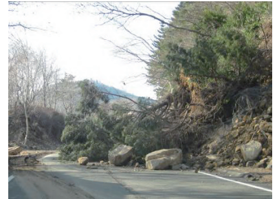
通行止めになった道路（牡鹿半島）
