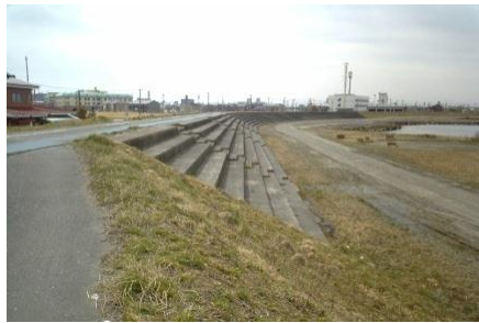
堤防の川側。階段が整備され、河川をゆっくり見ることができる
