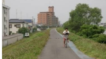
堤防上は安全な通学路
