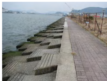
予定地下流側には水辺に親しめる 階段状の護岸がある(親水護岸)。
