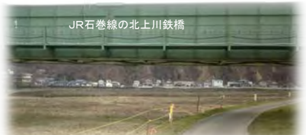
北上川鉄橋付近の河川敷。今後の利活用が期待される
