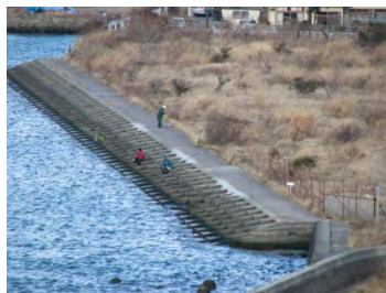
予定地下流側には水辺に親しめる 階段状の護岸がある(親水護岸)。
