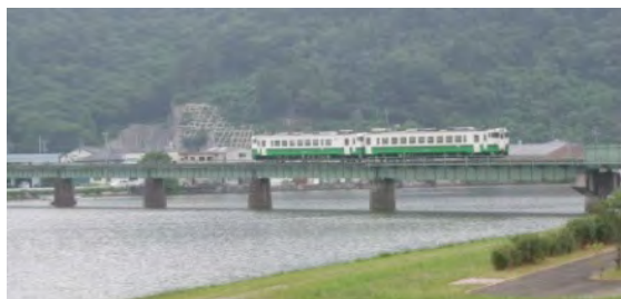
散策路からは鉄橋を通る電車(JR石巻線)が眺められる。昔と変わらぬ風景。
