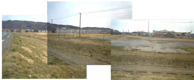
堤防の住宅側の状況(公共用地が約6ha)
